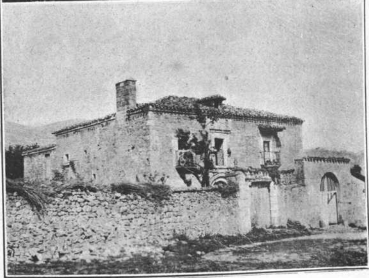
7.—Torre del palacio de Alonso de Huidobro. 8.—Casa de Fernández Quintano.
