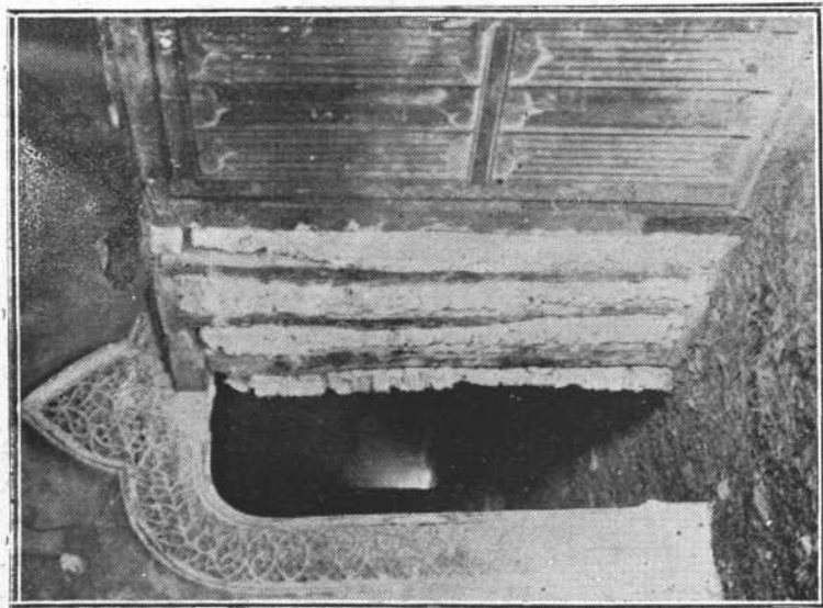
5.—Yesería y puerta del interior de la torre de Loja.
